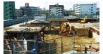
小川駅西口の工事の様子
